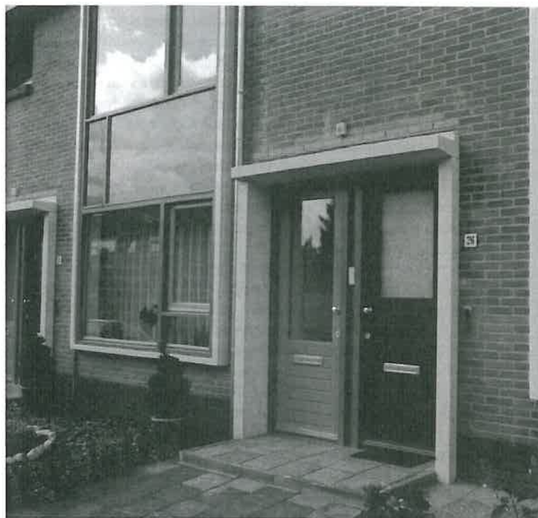
Hout is bezig aan een opmars bij renovatie van kozijnen. Onder meer een betere uitstraling van de woningen blijkt een doorslaggevende keuzefactor
